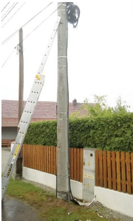
zdj. 1 Wykop z rurą RHDPE
