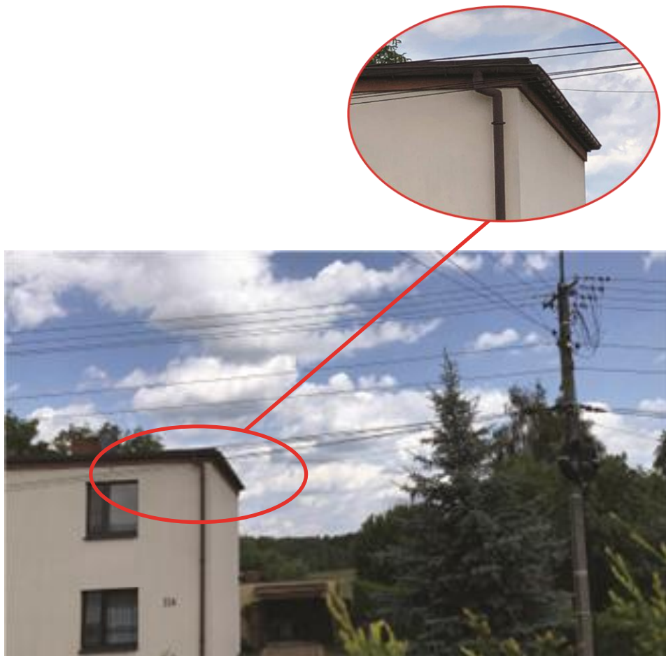
zdj. 5 Montaż światłowodu do elewacji budynku
